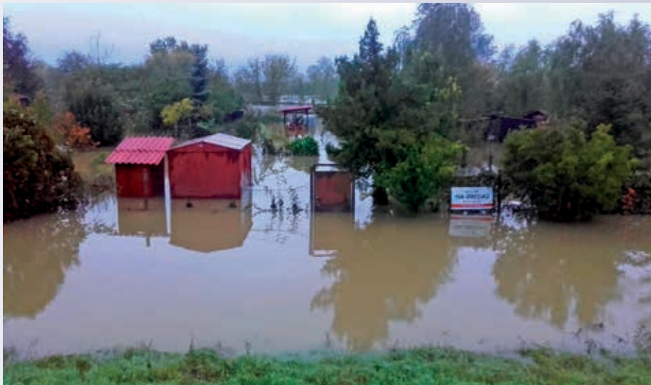
Zaplavenie záhradkárskej oblasti v povodí rieky Nitry
